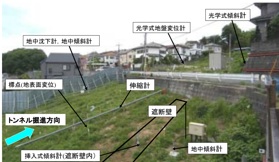
写真-2 起点側坑口部における計測工の配置状況
