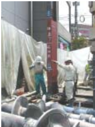
写真-2 矩形管建て込み状況
