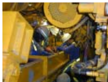
取り外し装置設置
