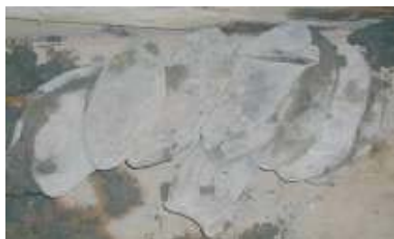
写真-3 EW 工法による非電食片
