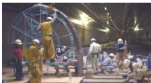
写真-14 函内打設状況（打設補助機）
