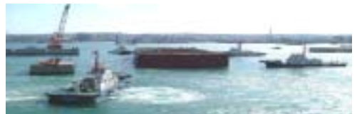
写真-9 函体曳航状況
