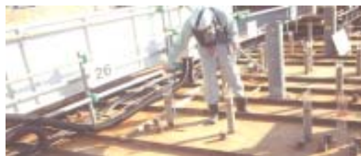
写真-17 現場管理（充填管理 その1）
