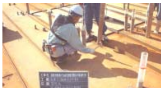
写真-18 現場管理（充填管理 その2）
