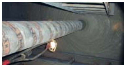
写真-15 コンクリート自己充填状況（隔壁内）
