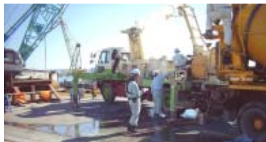
写真-16 現場管理（圧送管理・可使時間管理）
