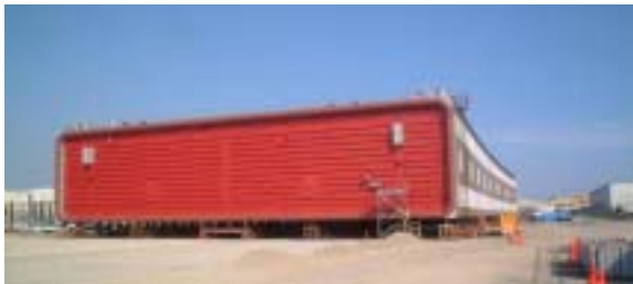
写真-2 鋼殻完成
