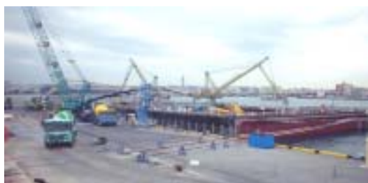
写真-12 浮遊打設の状況 [棧橋より望む]
