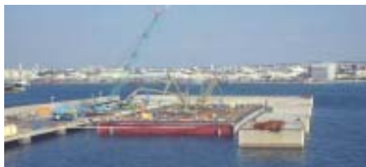
写真-11 浮遊打設の状況 [全景]
