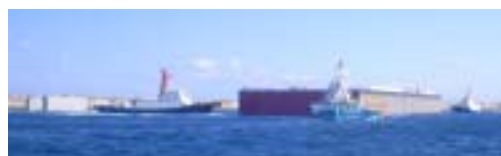
写真-8 鋼殻曳出状況
