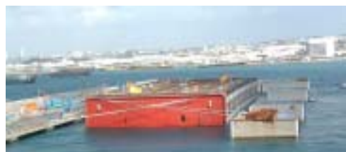
写真-10 函体係留完了
