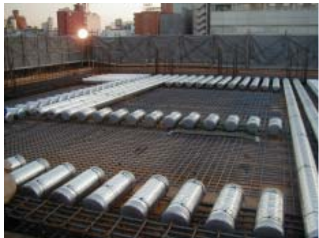
写真-3 ボイドスラブの全体敷設状況
