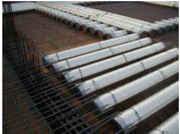
写真-2 ボイドスラブの施工状況
