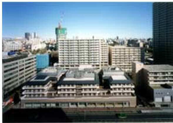
写真-1 建物外観
