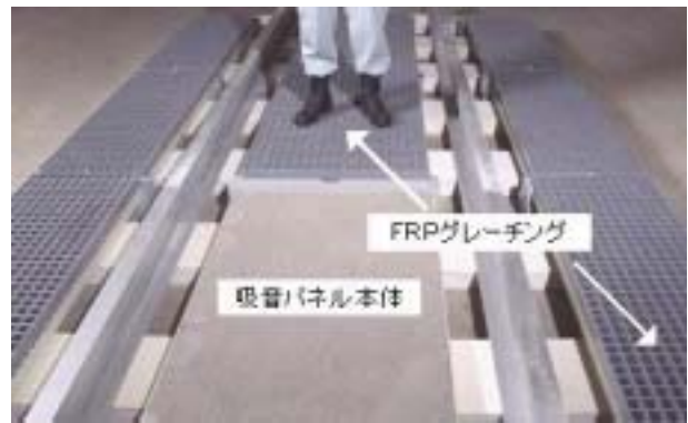
写真-1 鉄道スラブ軌道面用吸音パネル
