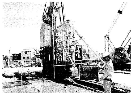
写真-1 TRD地中連続壁施工状況
