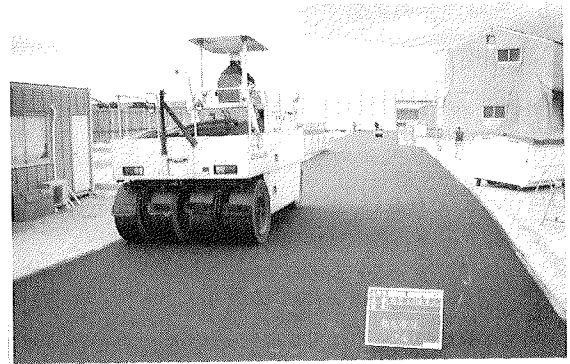
写真-10 運搬路舗装状況
