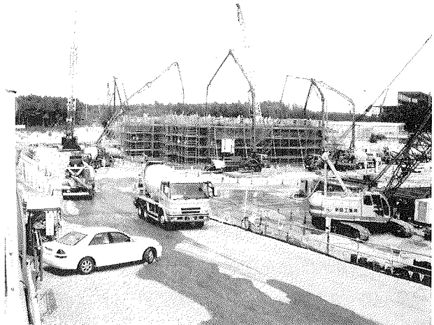
写真-7 対象構造物の施工状況 (打設)
