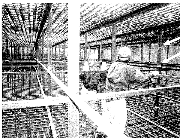
写真-11 打上がり速度目標の設置
