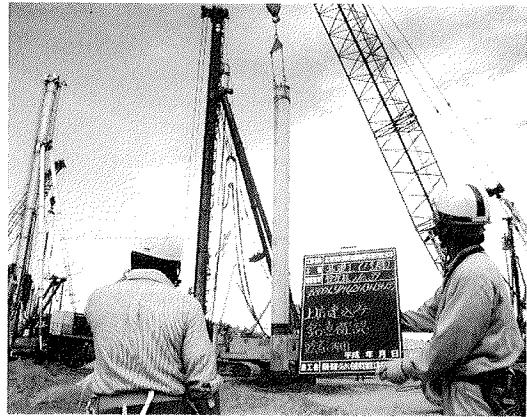
写真-2 基礎杭打設状況
