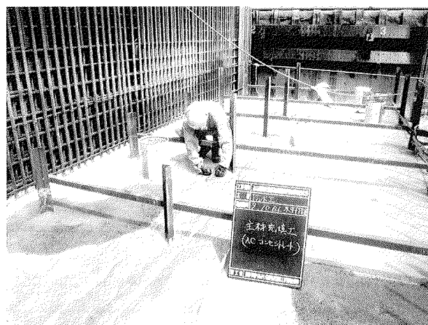
写真-12 水平施工打継ぎ面の止水対策
