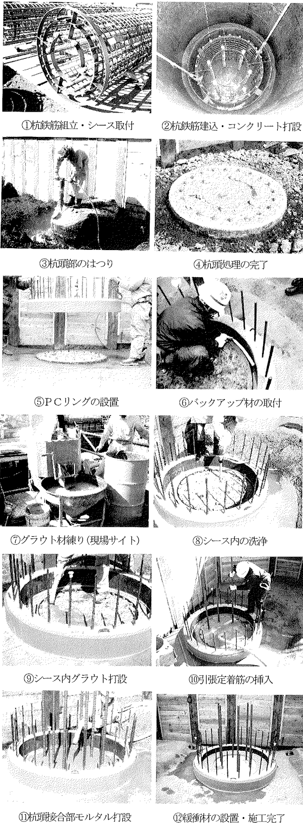
写真-3 施工手順
