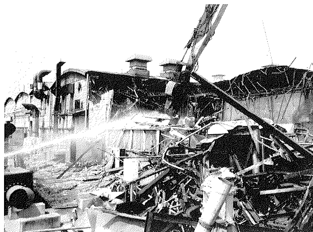
写真-7 構造物の解体DABW放水状況②
