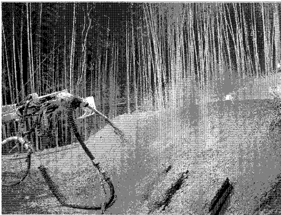
写真一 試験吹付け状況
