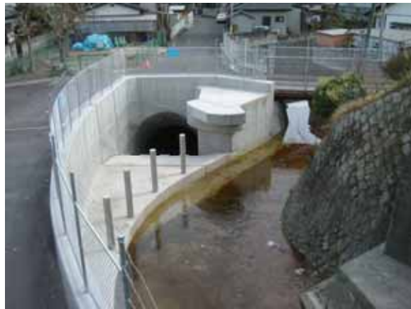
写真－6 分流工の完成状況
