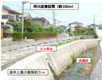
写真-2 河川近接部の地表状況
