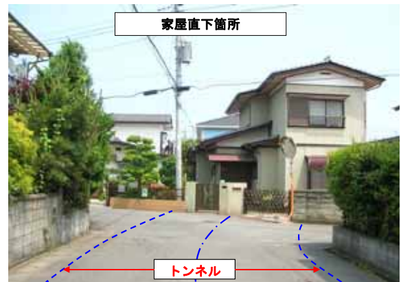
写真-1 家屋直下部(土被り約5m)の地表状況
