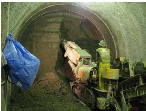
写真－4 泥岩層の掘削状況
