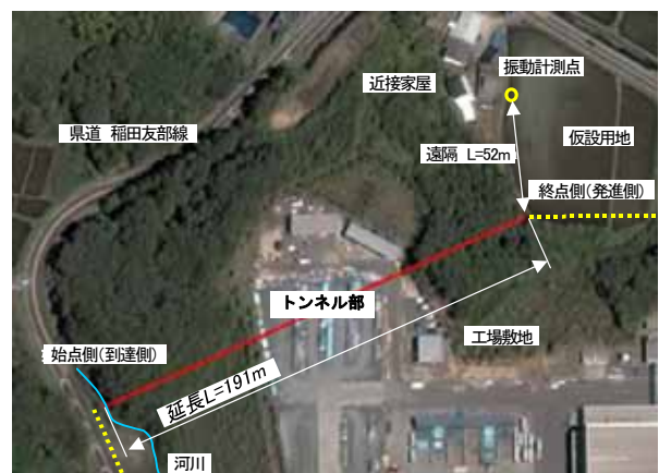
写真-1 施工箇所の航空写真
