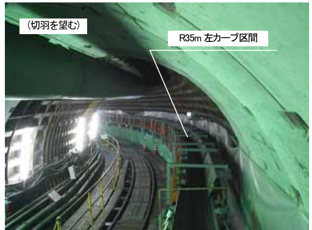
写真-4 R35m (左カーブ 区間)
