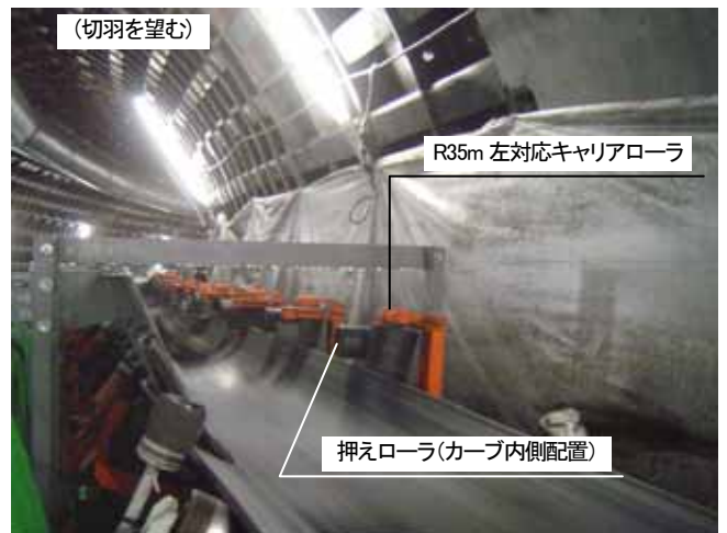
写真-5 R35m 区間キャリア側 (右カーブ 入口)
