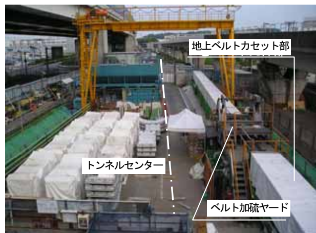
写真-2 地上カセット配置状況
