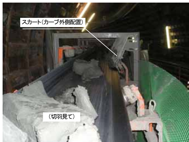
写真-8 R35m区間土砂塊対策スカート
