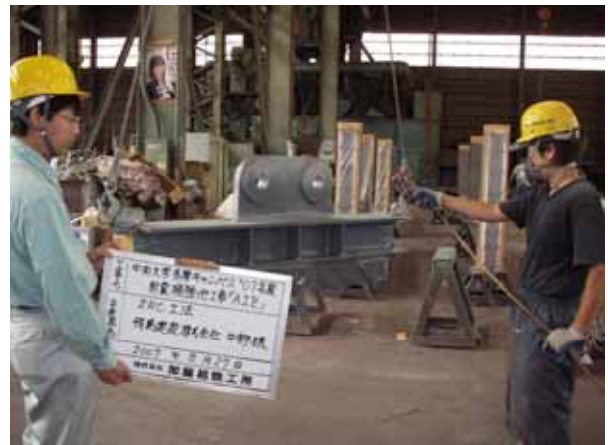
写真3 ZRC（常温亜鉛メッキ）工場塗装状況
