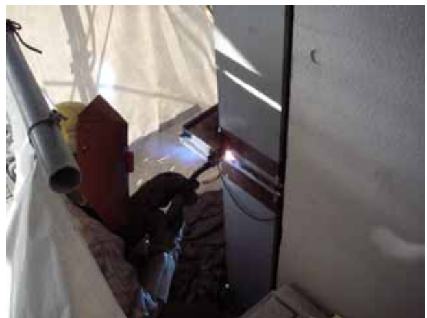
写真10 鉄骨柱溶接状況
