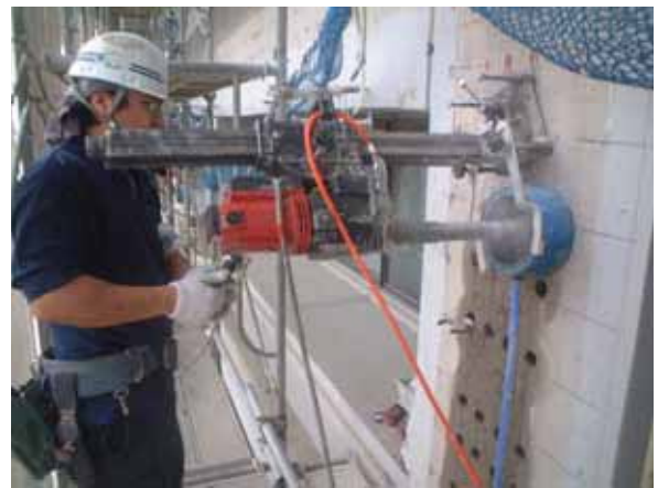
写真2 スタッドアンカーコア削孔状況
