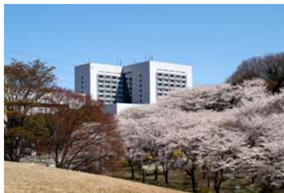
写真1 2 2号館南面（A通）完成状況
