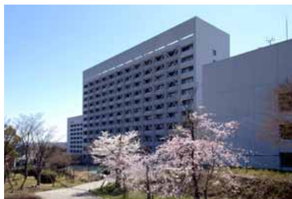
写真1 3 2号館北面（F通）完成状況
