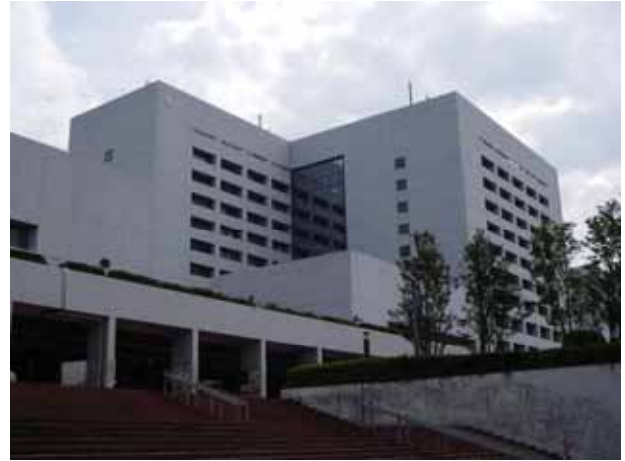
写真1 2号館南面補強前
