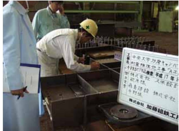
写真7 鉄骨試作品検査状況
