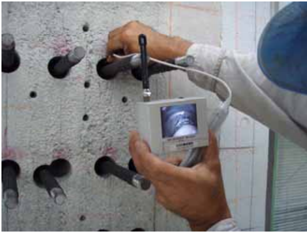
写真5 溶接部確認状況
