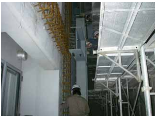
写真9 鉄骨建方状況
