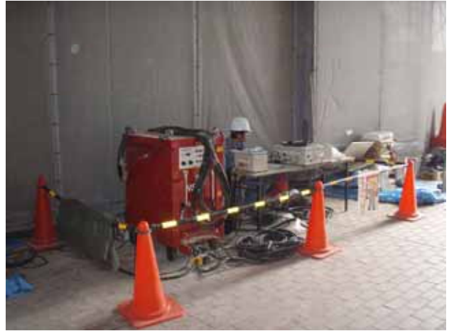
写真4 スタッド打設モニタリング状況
