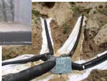
写真-4 有孔管による地下排水工
