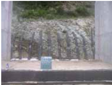
写真-4 有孔管による地下排水工
