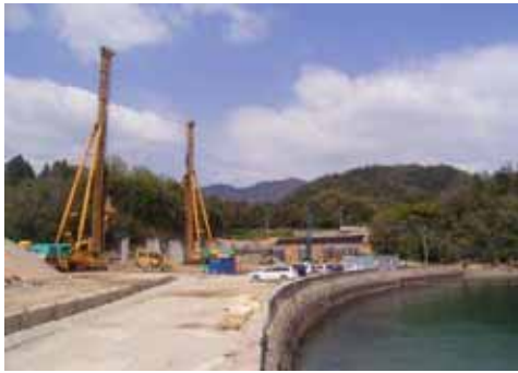
写真-2 サンドコンパクションパイル打設状況
