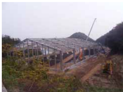
b) 鉄骨の組み上げ状況
