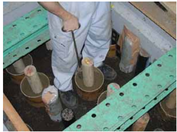
写真-2 砂による被覆状況
