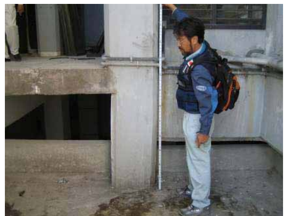
(b) 建物の被害調査
