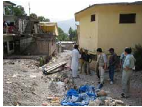
(b) 地盤変状の調査（住民への聞き取り）
