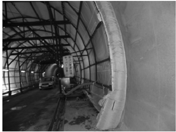
写真-2 送風後の密閉材の状況
