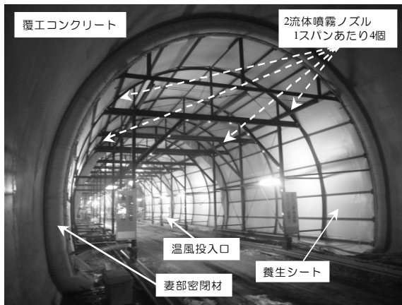
写真-1 連続養生システムの全景
