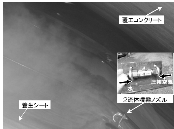
写真-3 噴霧養生の状況
