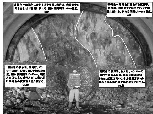
写真-2 NO.335+1.8での切羽状況（切羽評価点31）
