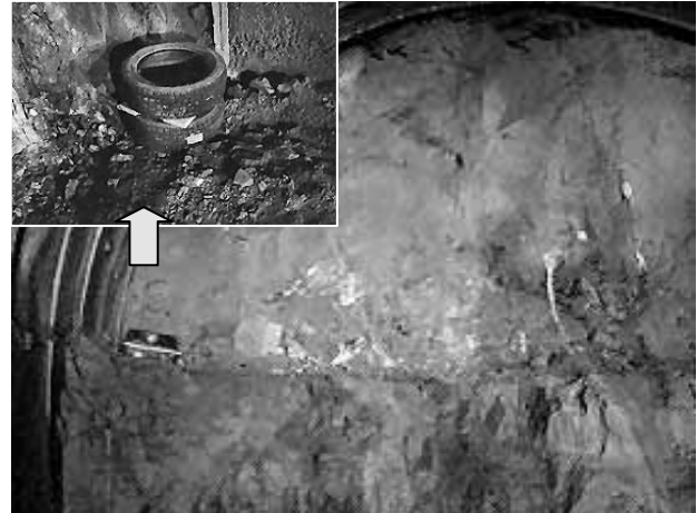
写真-3 切羽での振動速度計の設置状況
