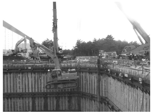
写真-1 施工重機吊降し状況
