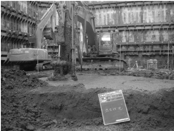
写真-2 施工状況
