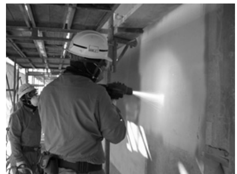
写真-6 常温金属溶射の状況
