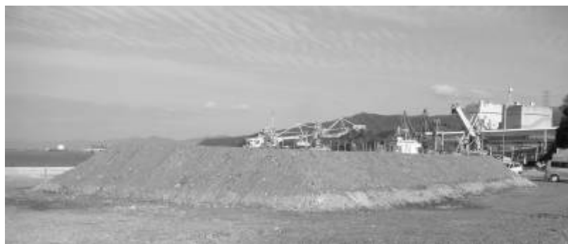
写真-3 盛土造成後
