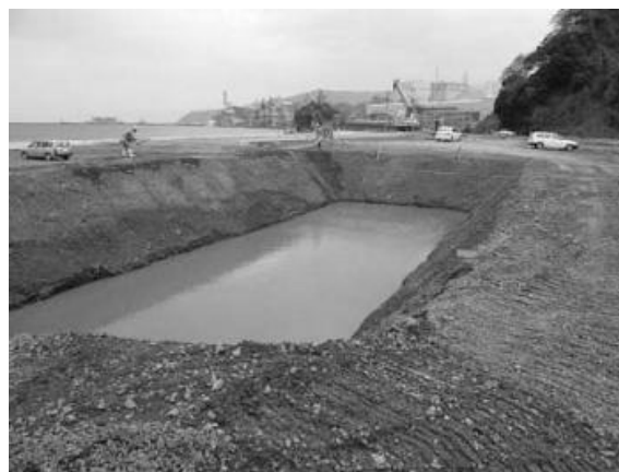
(a) トレンチ掘削完了
