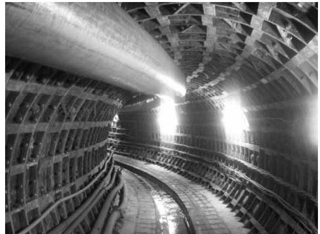
写真-1 鋼製セグメント区間の全景
