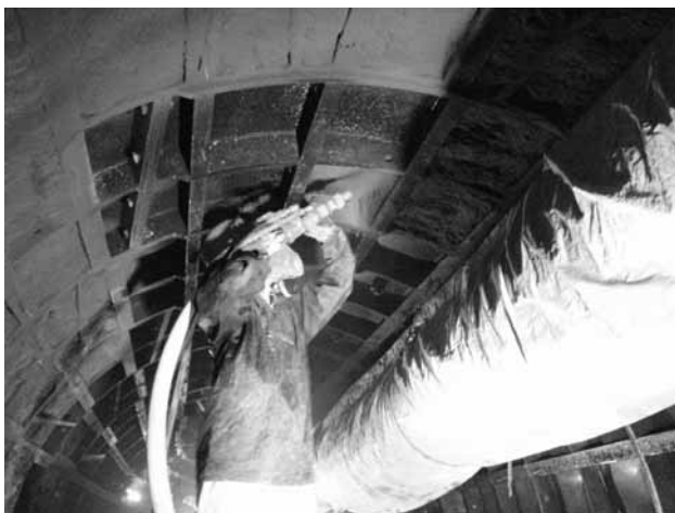
写真-3 充填モルタルの吹付け状況
