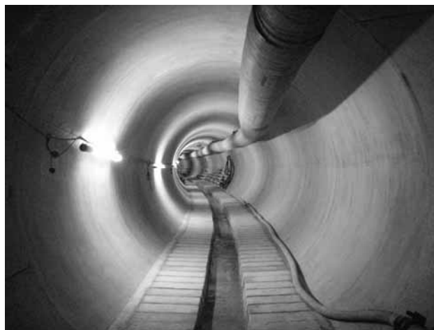
写真-5 完成後の全景
