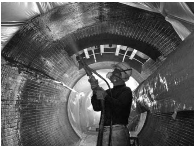
写真-4 耐硫酸モルタルの吹付け状況
