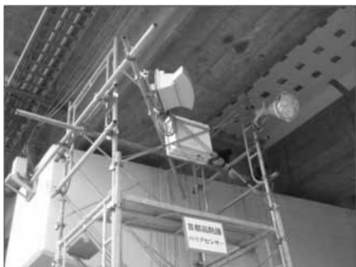
写真-2 バリヤセンサー設置状況
