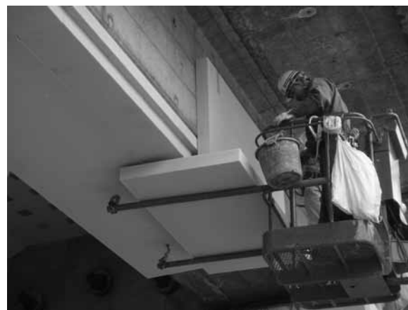
写真-1 損傷防護材設置状況
