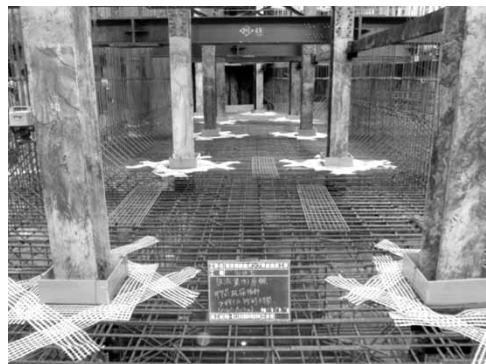
写真-4 ガラス繊維ネット設置状況
