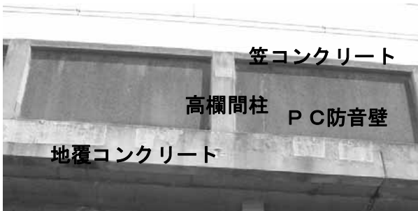
写真-1 比較的健康な間柱式高欄状態
