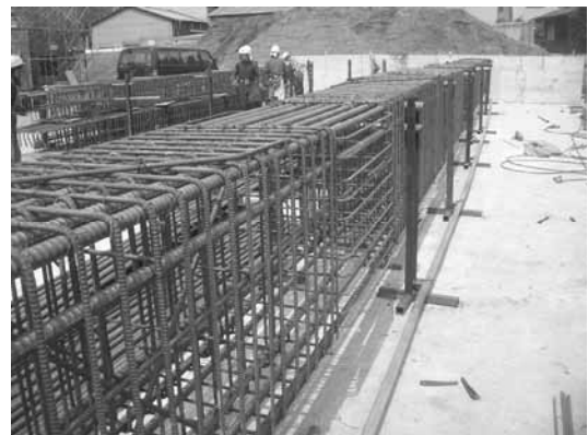
写真-5 鉄筋先組状況
