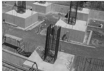
写真-3 打設完了後の状況
