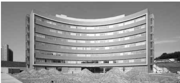
写真-1 建物全景
