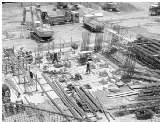
写真-4 先組鉄筋ヤード全景
