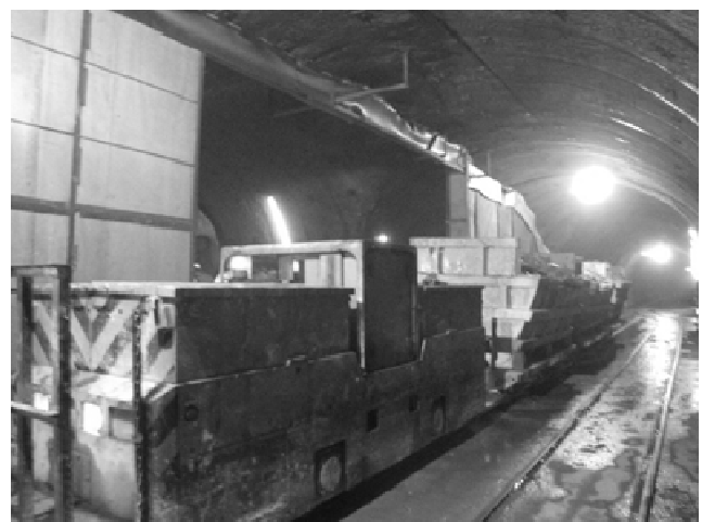
写真-2 ずり運搬状況（レール方式）
