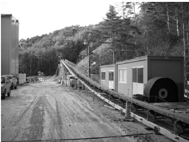
写真-10 ベルトコンベヤシステム (坑外)
