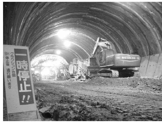
写真-8 ずり積込状況 (切羽側)
