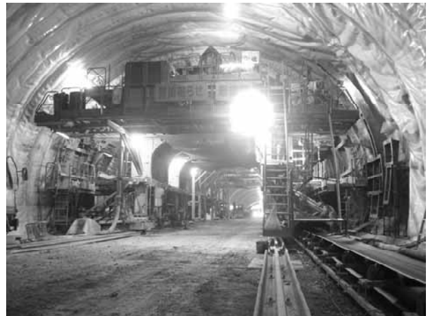
写真-9 ベルトコンベヤセントル通過状況
