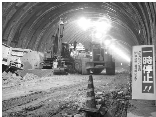
写真-7 ずり積込状況 (坑口側)
