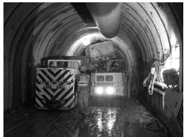
写真-1 ずり積込状況（切羽）
