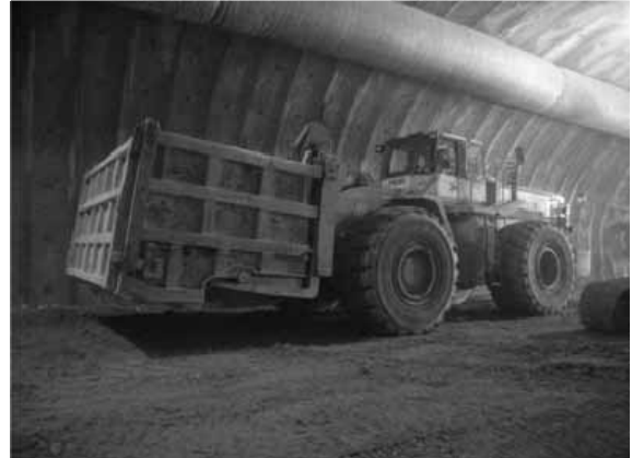
写真-6 ずり運搬状況
