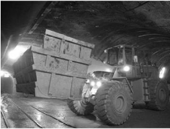
写真-3 ベッセル入替え状況 (連絡坑)
