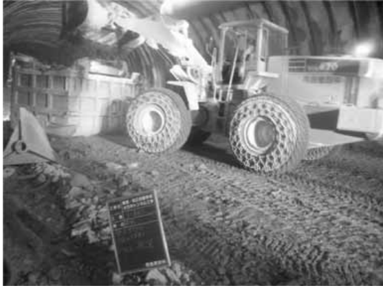
写真-5 ずり積み状況 (切羽)
