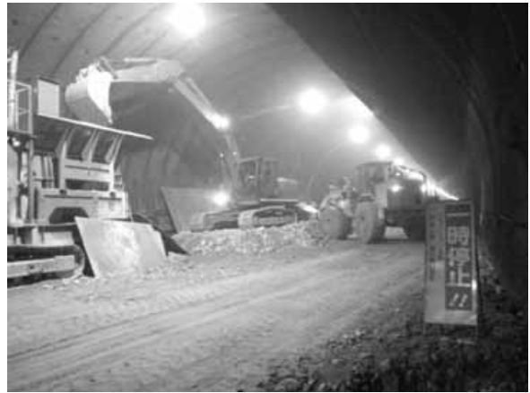
写真-4 クラッシャーまでのずり運搬 (本坑)
