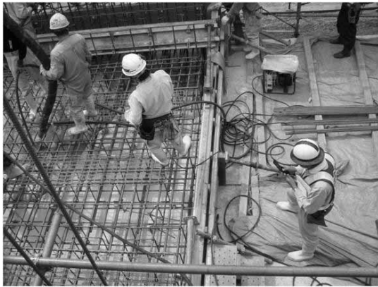
写真-2 コンクリート打設状況
