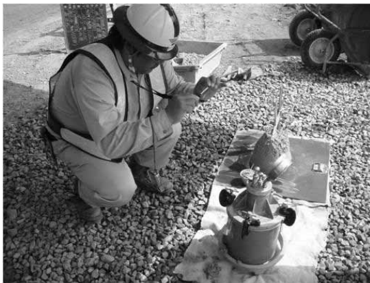
写真-3 品質検査状況
