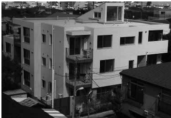
写真-1 建物外観
