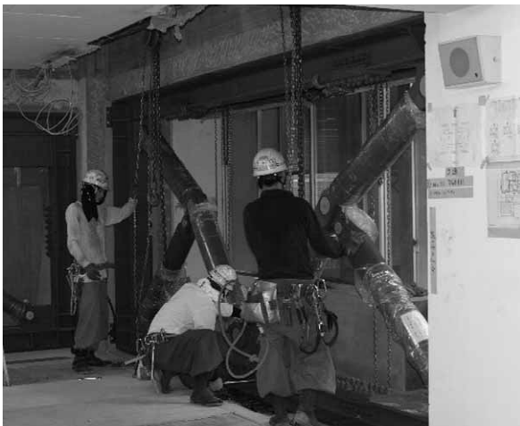
写真-2 耐震改修工事の状況 (トグル制震装置の取り付け状況)
