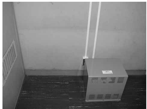
写真-5 地上1階の地震計設置状況 (地震計カバーを付けた状態)
