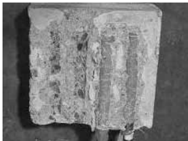
写真-1 上向き施工のアンカー内部の様子
