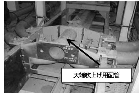
写真-2 天端吹上げ用配管の改善
