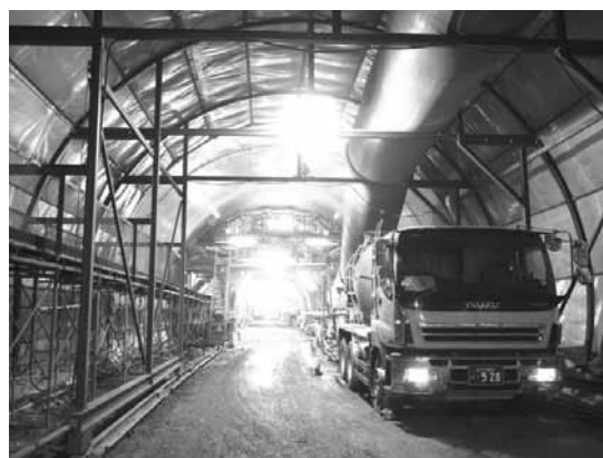
写真-3 3スパン連続覆工コンクリート養生台車
