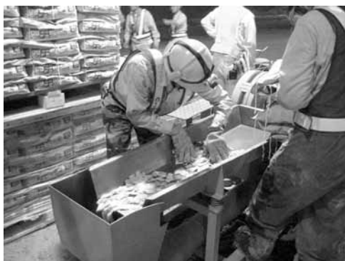
写真-5 坑内での鋼繊維投入状況
