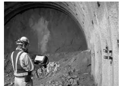
写真-5 鋼製支保工への設置例
