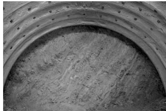
写真-7 上半切羽状況：軽石凝灰岩
