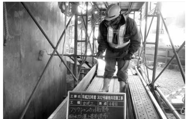
写真-1 摩擦低減塗装状況
