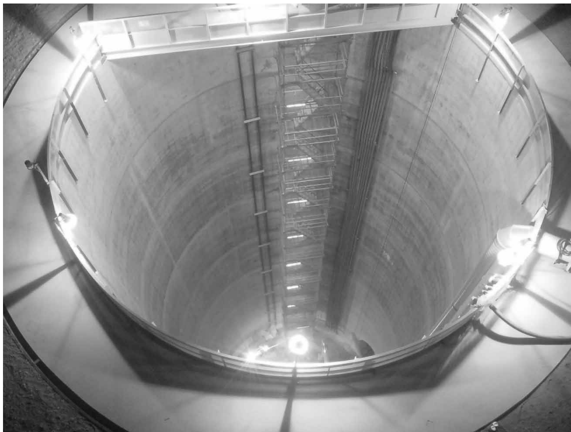
写真-5 緑地立坑完成状況
