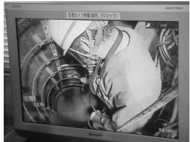
写真-4 アンカーリング部充填監視画面
