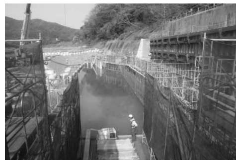
写真-7 注水状況
