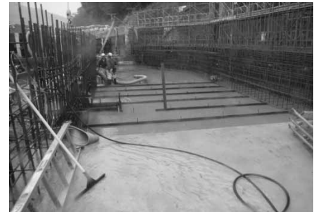
写真-13 排水完了
