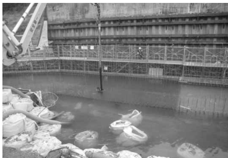
写真-11 潜水士による打設作業状況
