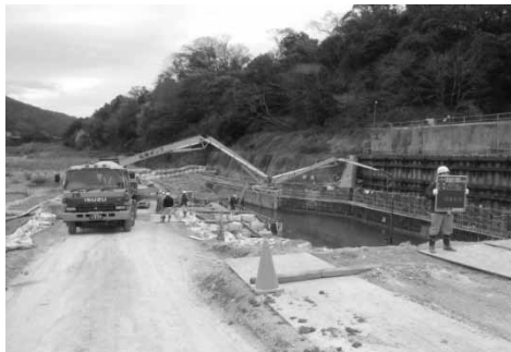
写真-10 水中コンクリート打設状況
