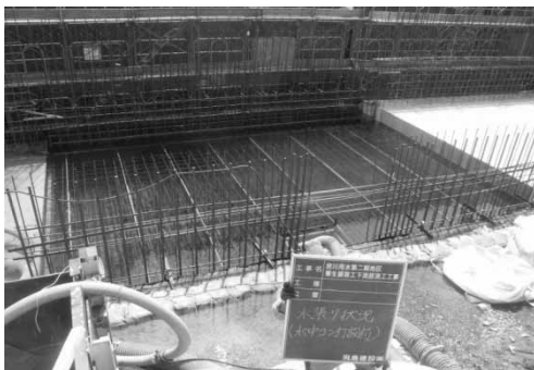
写真-6 仕上がり天端の明示(ヌキ板の設置)
