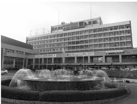
写真-1 仙台市役所本庁舎の全景 (平成21年10月撮影)
