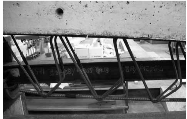
写真-3 端部ラチス筋の座屈 (TR-25-L)
