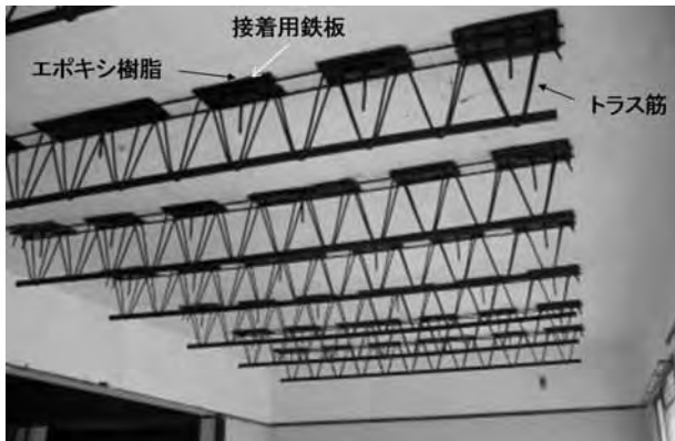
写真-2 補強部材取付状況 (トラス筋)
