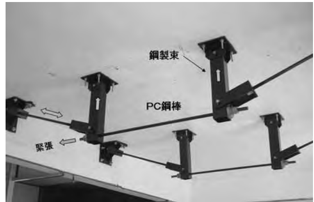
写真-3 補強部材取付状況 (PC 鋼棒)
