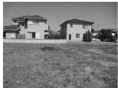
写真-33 噴砂と塀, 民家の沈下
