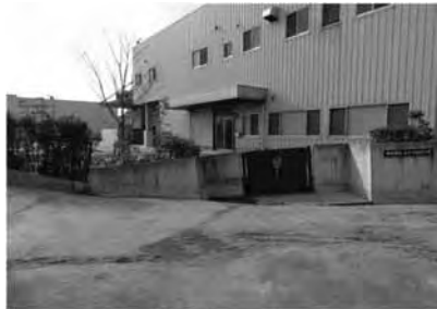
写真-20 門、塀の傾斜、大量の噴砂
