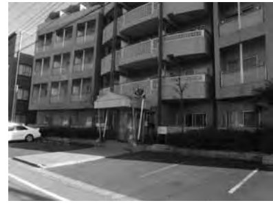
写真-42 越谷市千間台の集合住宅 沈下が進行
