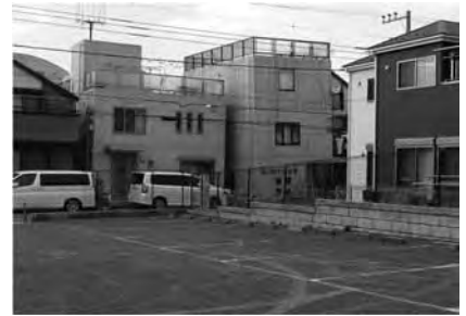
写真-18 戸建住宅の傾斜
