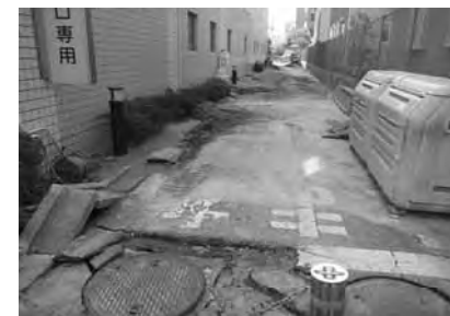
写真-9 外構ブロックの座屈、大量の噴砂
