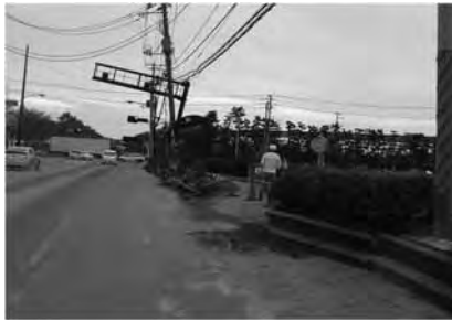
写真-16 道路標識・電柱等の傾斜、歩道の傾斜
