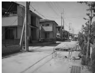
写真-32 すべての電柱が傾斜
