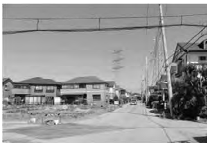
写真-31 住宅, 電信柱の傾斜, 道路沈下
