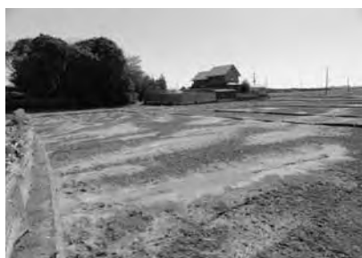
写真-28 農地の亀裂・流動・大量の噴砂
