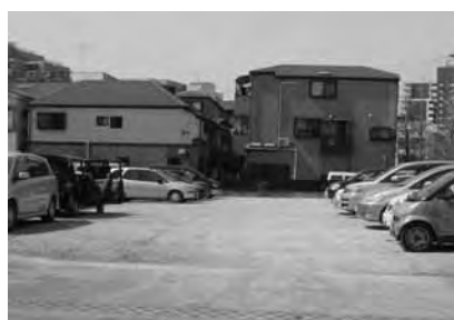
写真-10 戸建住宅の沈下・傾斜
