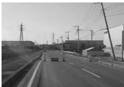
写真-35 道路の沈下、亀裂、段差
