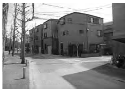
写真-11 戸建住宅の沈下・傾斜
