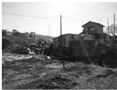
写真-26 法先の民家の変形, 埋設管浮上
