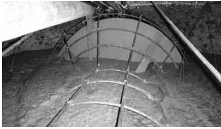
写真-10 コンクリートレベリング状況
