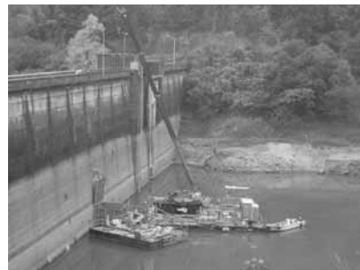
写真-3 仮締切施工状況
