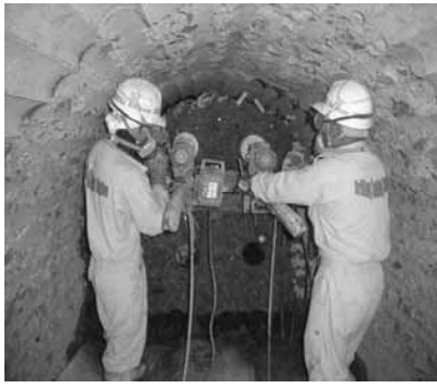
写真-1 外周部ボーリング状況
