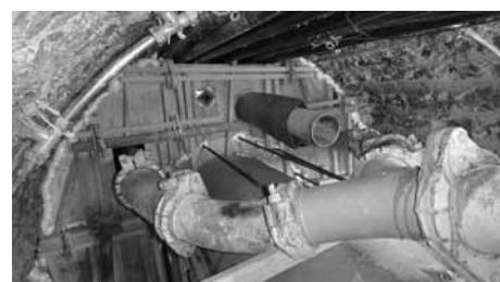
写真-8 コンクリート打設状況
