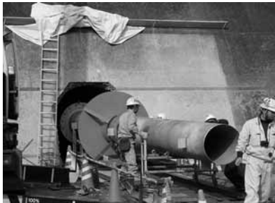
写真-4 放流管施工状況
