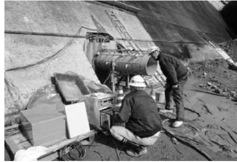
写真-11 コンタクトグラウト施工状況
