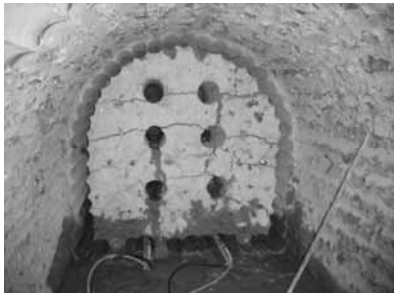
写真-2 クラッカーによる破碎状況
