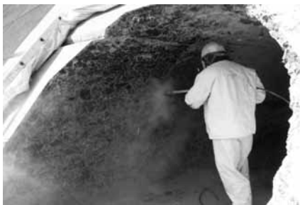
写真-5 目荒らし施工状況
