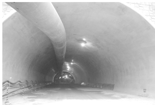
写真-4 覆工コンクリート打設完了（坑口部）
