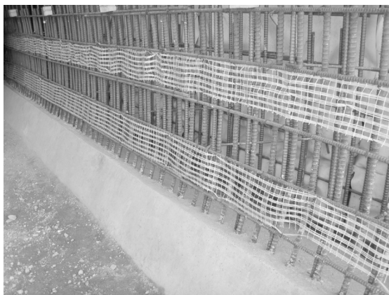
写真-1 耐アルカリ性ガラス繊維ネット設置状況
