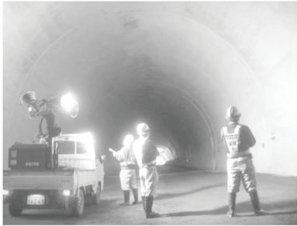
写真-1 トンネル技術者による美観性評価状況
