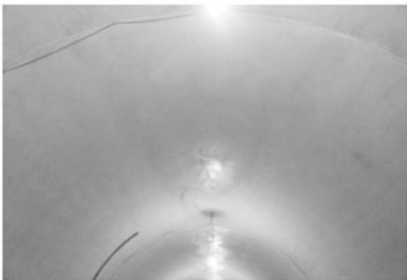
写真-5 中流動コンクリート (M-LS) の仕上がり状況
