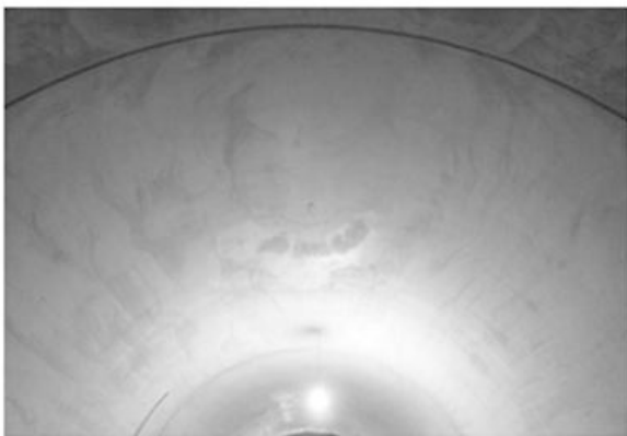
写真-4 通常の覆工コンクリートの仕上がり状況
