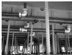
写真-7 モルタル注入配管
