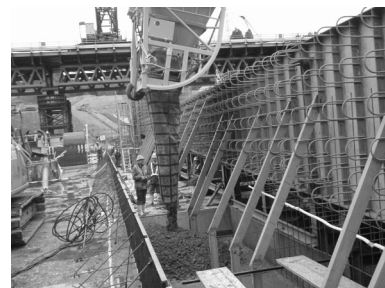
写真-8 コンクリート打設状況
