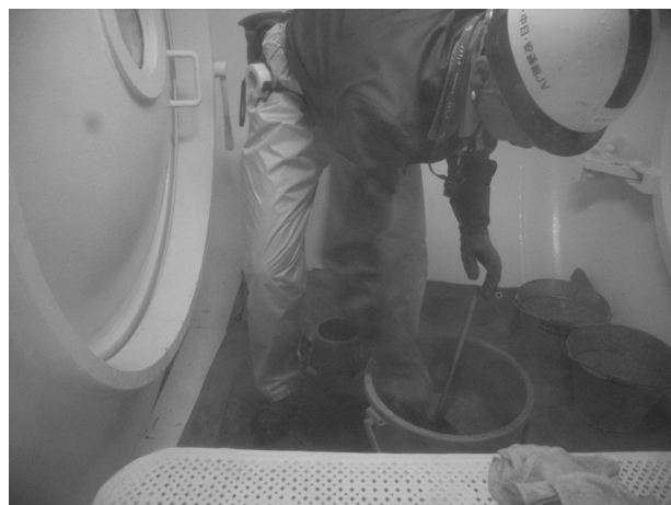
写真-2 再圧室内でのスランブ試験状況
