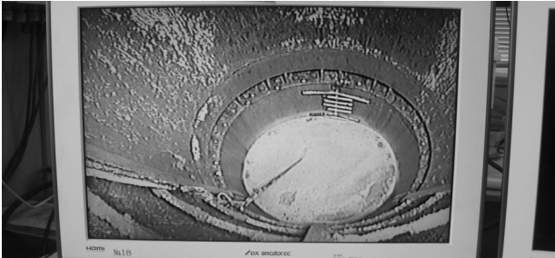
写真-5 シャフト内状況（断気時）
