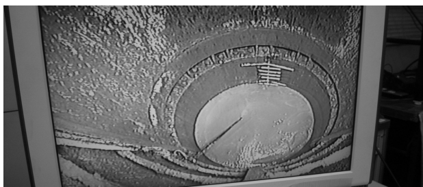
写真-4 シャフト内状況（打設完了時）
