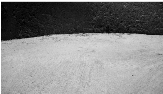
写真-7 コンクリート表面状況
