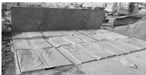
写真-5 セルダンパー防振マットの設置状況
