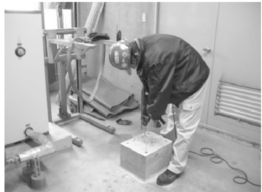
写真-4 穿孔作業の状況
