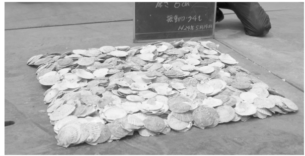
写真-6 貝殻の巻き出し厚さ6cmの状況
