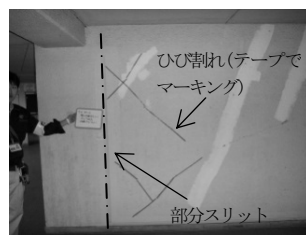
写真-3 3方部分スリットを設けた壁
