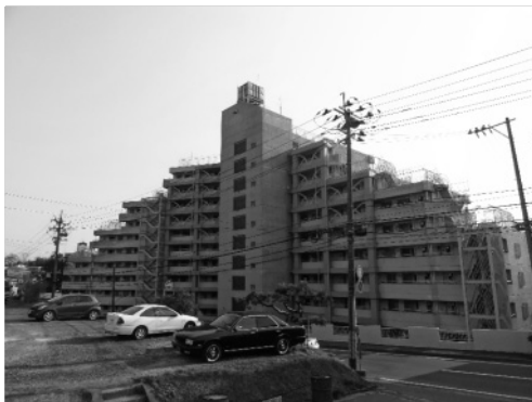
写真-1 耐震補強後の本建築物の全景
